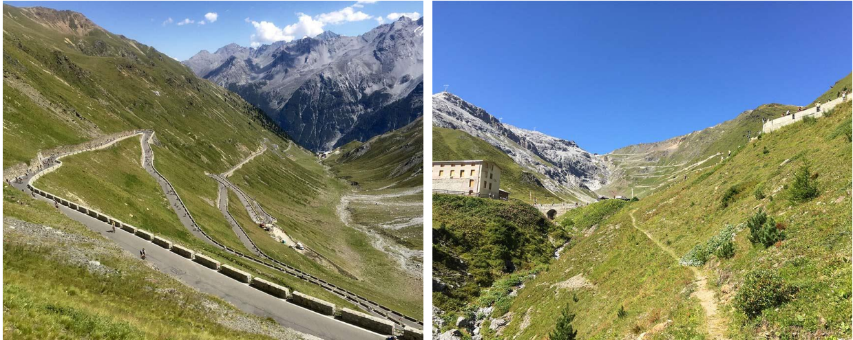
Figura 7.28: SS 38 “Strada dello Stelvio”
