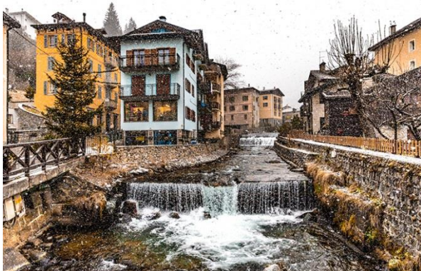
Figura 7.6: Ponte di Legno (BS)
