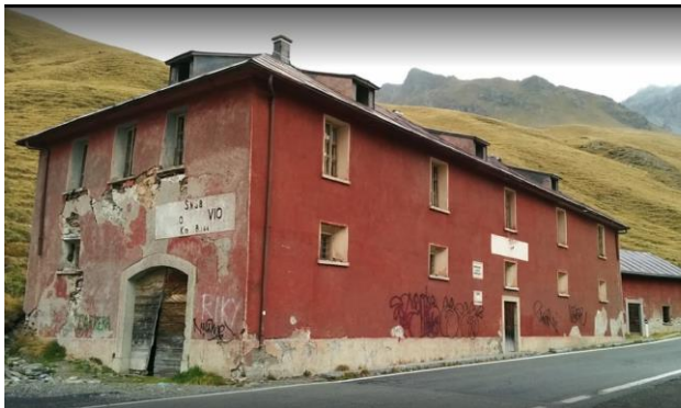
Figura 7.16: III Casa Cantoniera Stelvio
